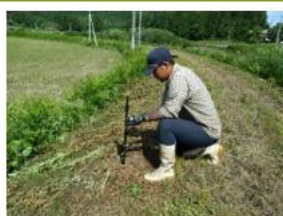
侵入防止の電気柵設置作業
